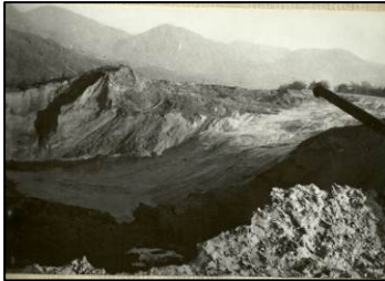
Fig. 3. Porțiunea avariată a iazului de decantare
