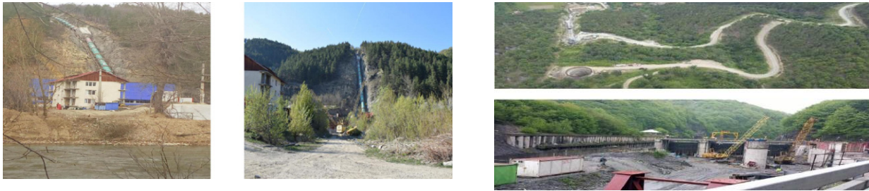
Fig. 2. Lucrări în zona Bumbști-Livezeni - iunie 2017
